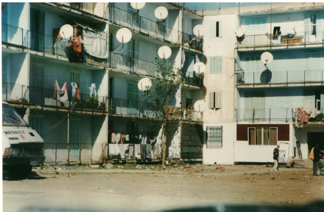
(15) الإطار المبنى يعيش فوضى عمرانية (تصوير رابح سعدان)
